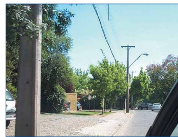
Postes al Borde de Calzada
