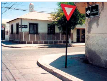
Intersección con baja visibilidad y «Ceda el paso», instalado incorrectamente
