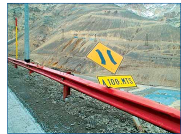
La señalización rayada, envejecida, o caída, no puede ser percibida en forma óptima por los conductores, generando situaciones de riesgo que pueden terminar en un accidente
