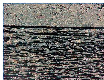
Superficie con tratamiento
