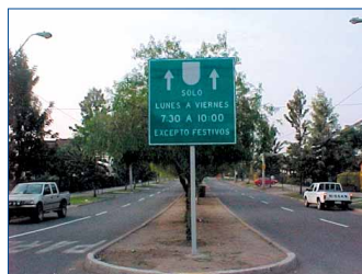
Vía con pista segregada para transporte público
