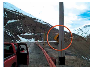
La señalización obstaculizada por condiciones climáticas o vegetación, y mal instalada, puede generar situaciones de riesgo para los conductores
