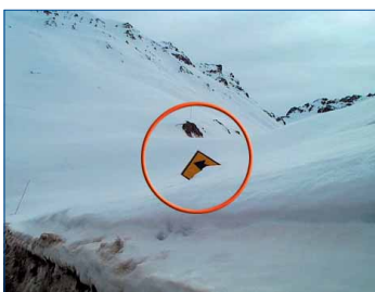
La señalización obstaculizada por condiciones climáticas o vegetación, y mal instalada, puede generar situaciones de riesgo para los conductores
